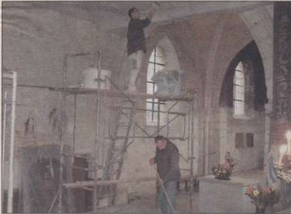
Des travaux importants en terme de sécurité.
