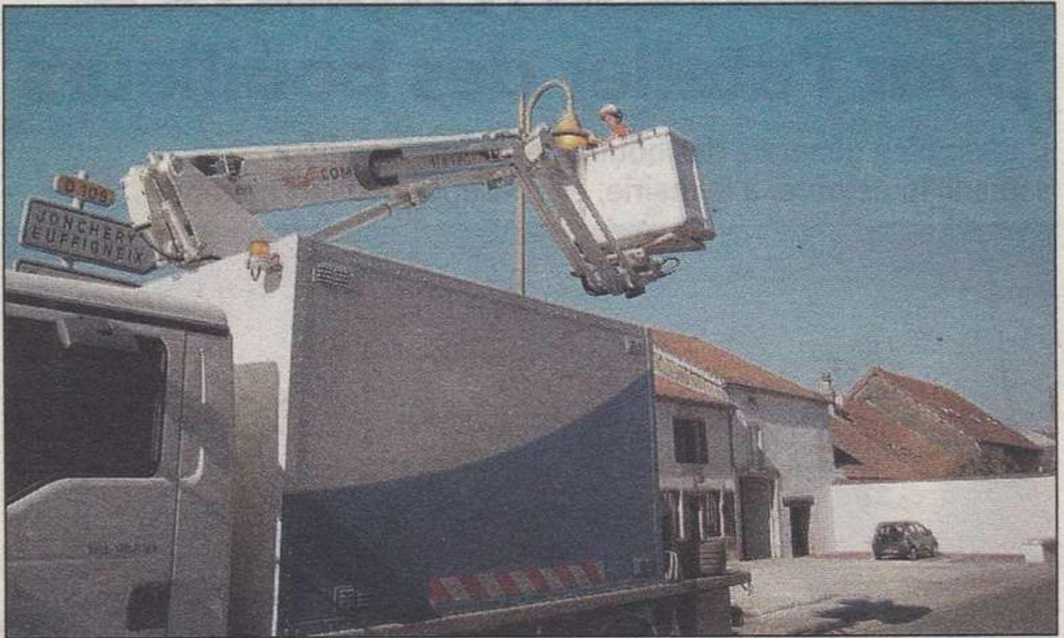
A l'entrée de l'hiver, l'éclairage public doit être au top, ce qui nécessite un contrôle. L'entreprise Sauterne, qui a en charge l'entretien, a remplacé plusieurs ampoules défectueuses et a effectué plusieurs nettoyages de faux contacts sur les 250 lampes environ. Deux visites par an sont ainsi réalisées sur le réseau électrique de la commune.
