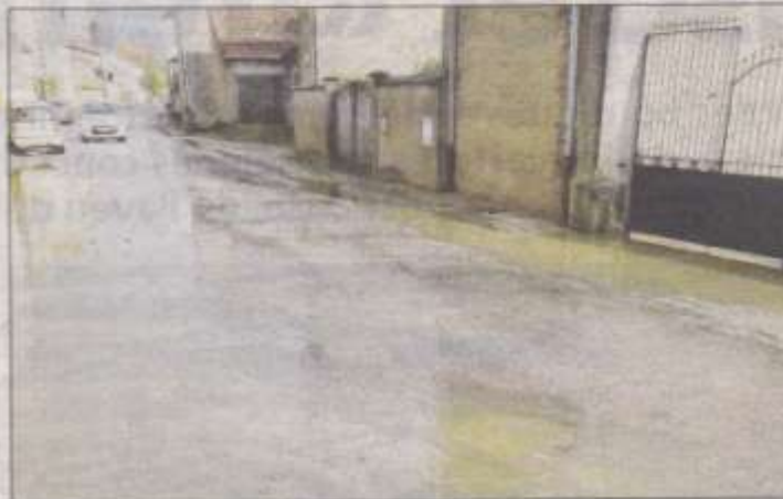
De gros dégâts dans certaines communes. (Photo d'archives B.T.).
